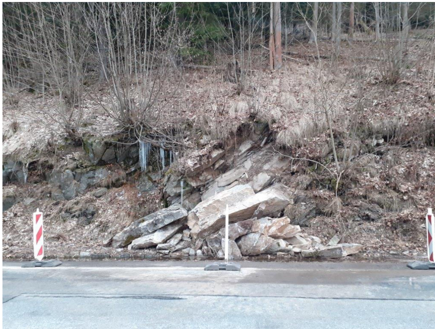
Malé skalní řícení v lokalitě Herlíkovice, v km cca 13,315 silnice II/295, dokumentované 11.03.2021 (foto inspektor siln.sítě M. Krampla)
