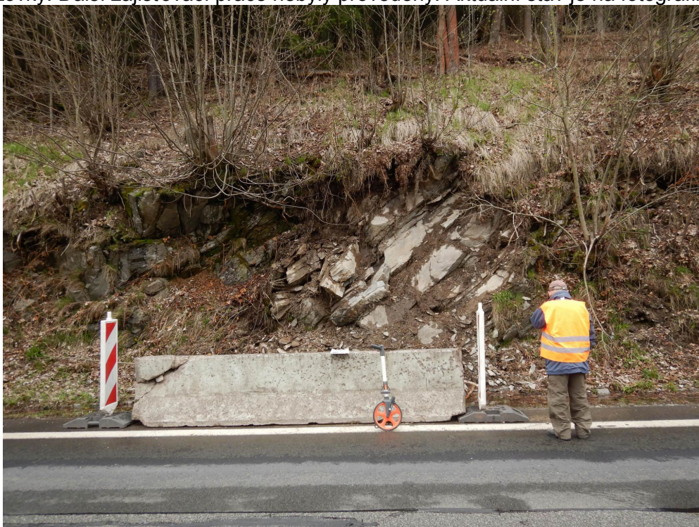
Elementárně zajištěný prostor skalního říčení (foto 03.05.2021)
